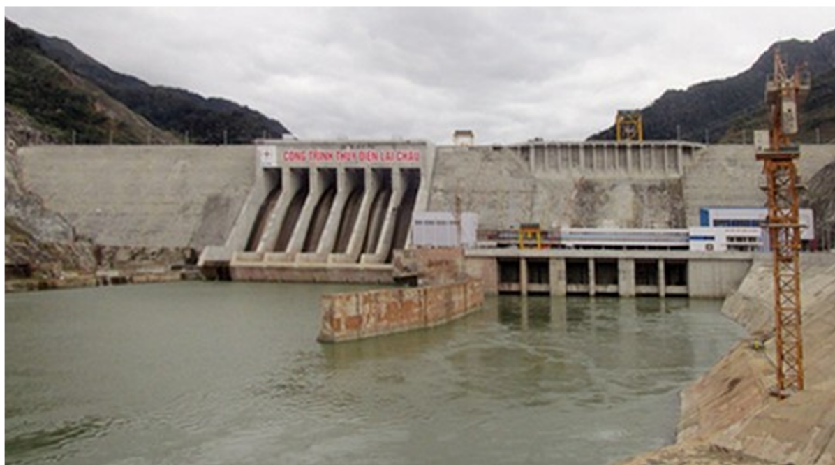
Công trình Thủy điện Lai Châu
